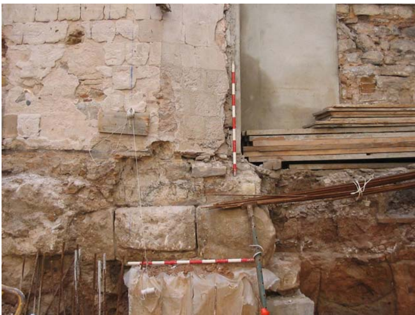
Foto 12. Detall de l'estat actual del pilar.
